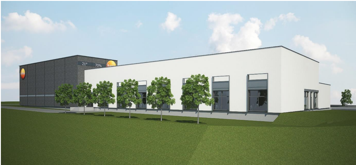
Bild 2: Rückansicht des Bauprojekts im Gewerbegebiet Fischerrain in Kirchzarten
