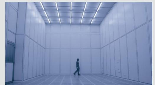
Reinraum der Luftreinheitsklasse 1 nach ISO 14644-1 in der Abteilung Reinst- und Mikroproduktion
