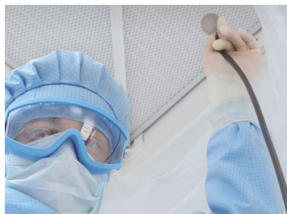
Durchführung eines Filterlecktests
